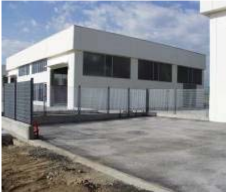
Capannoni artigianali e industriali, siti in Scalenghe (TO)
